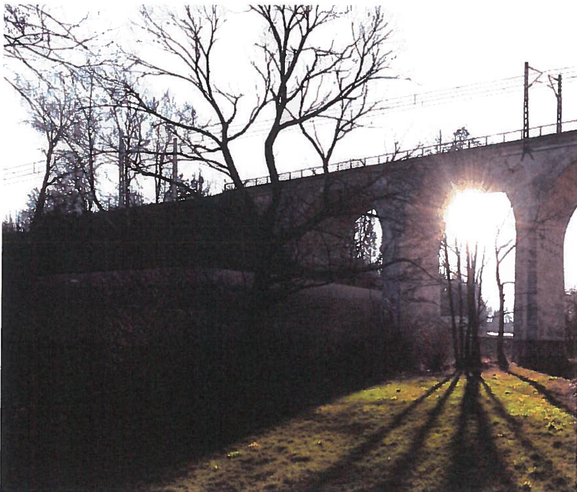
Auf der Egertalbrücke in Marktleuthen stehen künftig Oberleitungsmasten (Fotomontage).
