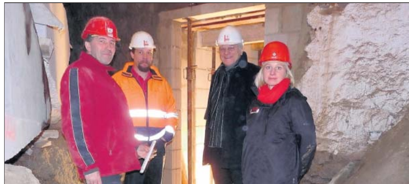
Auf der Baustelle (von links): Bauleiter Jürgen Löhner, Polier Johannes Burger, Seniorchef Werner Weiß und Geschäftsführerin Veronika Sirch von der Wunsiedler Firma Roth.
