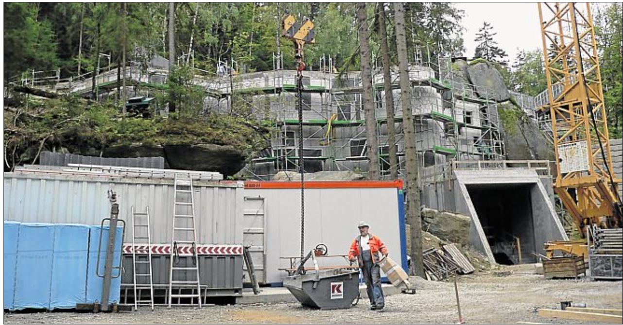
Rund 15 Millionen Euro kosten die umfangreichen Umbaumaßnahmen auf der Luisenburg. Die Arbeiten auf 700 Metern Höhe laufen auch im Winter weiter. Bild: hzf
