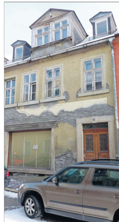
Im Haus Am Bocksberg 3, das Besitz der Stadt ist, könnte einmal das zentrale Stadtarchiv untergebracht werden. Foto: Bäumler
