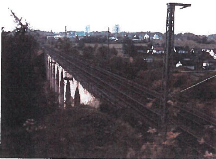
Bereits seit 2013 elektrifiziert: Die Strecke Reichenbach–Hof (im Bild: Saalebrücke bei Unterkotzau)
